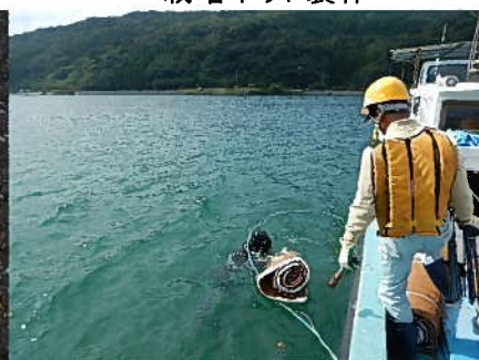
潜水土マット設置
